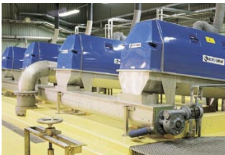
Installation der Roto-Sieve Trommelsiebe Modell 51 in der Abwasserreinigungsanlage Kullavik, in Kungsbacka, Schweden.
