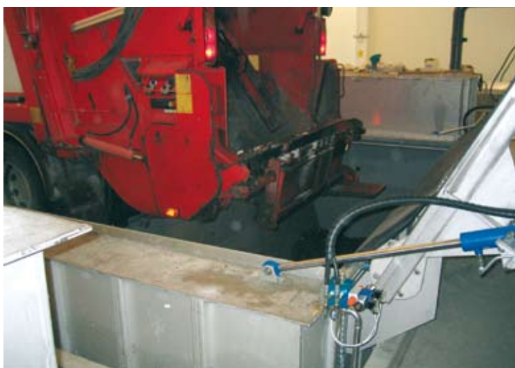
Tippning av hushållsavfall i en av de installerade mottagningsfickorna.
