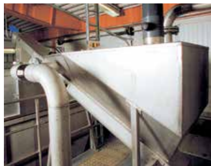
Installation av Läckeby Products avvattnare SA 260-50.
